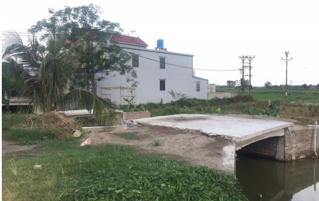
Hình 3.2. Cầu dân sinh được người dân xây kiên cố bắc qua tuyến kênh thủy lợi tại xã Kiến Thiết
