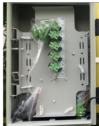
Hình 3-15: Hình ảnh thực tế hộp Splitter cấp 2 loại 1:16
