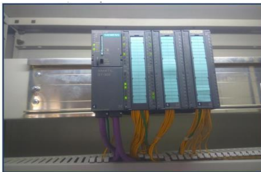
Hình 3.7. PLC S7-300 (CPU 313C - 2DP) và các module mở rộng.
