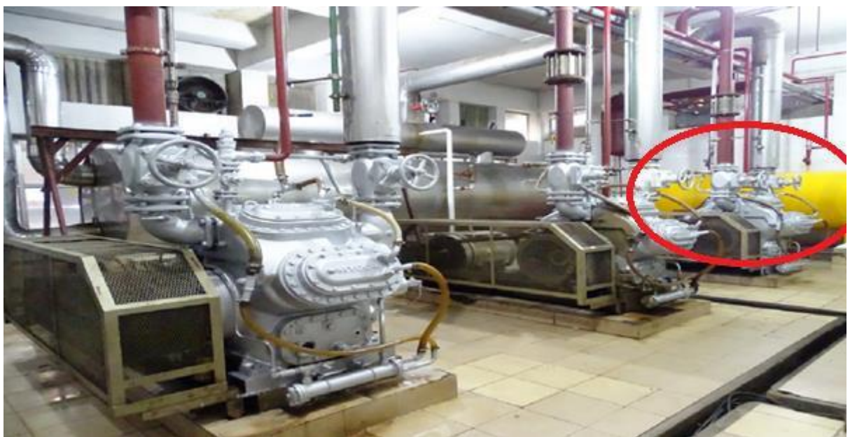
Hình 3.10. Bình lỏng bơm cao áp của máy nén.
