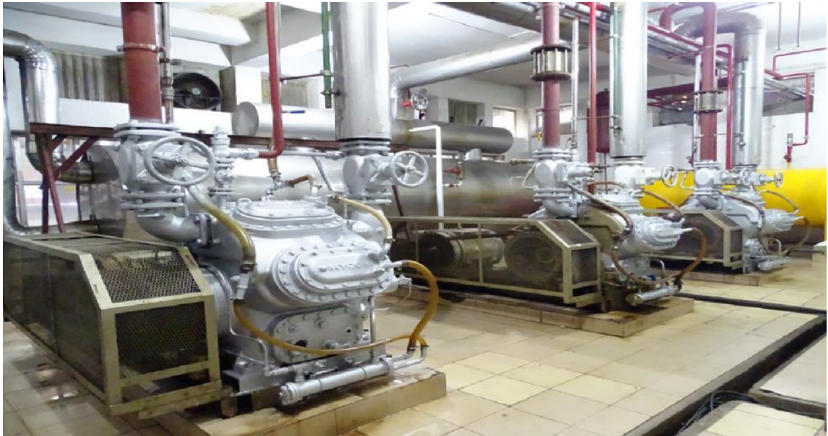
Hình 1.6. Hệ thống lạnh NH 3 Công ty bia Heineken.
