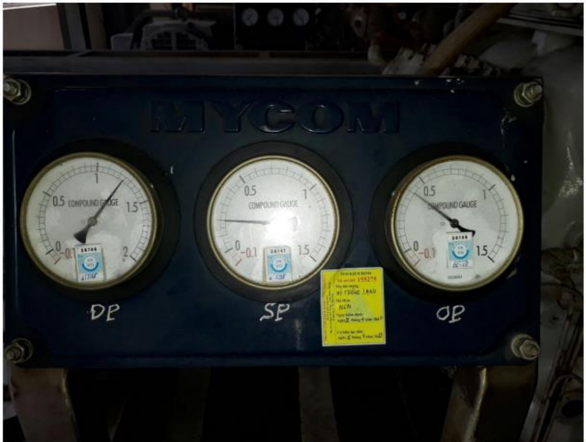
Hình 3.11. Đồng hồ đo áp suất( cửa đẩy, cửa hút, dầu )máy nén.
