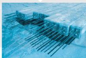
Đúc thành trụ cốt thép
