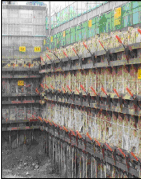
Hình 1.2 : Neo đất của tầng hầm nhà cao tầng [22]
