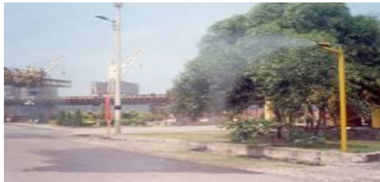
Hình 3.3: Hình ảnh một đoạn hệ thống phun sương giảm thiểu bụi tại Công ty tuyển than Cửa Ông
