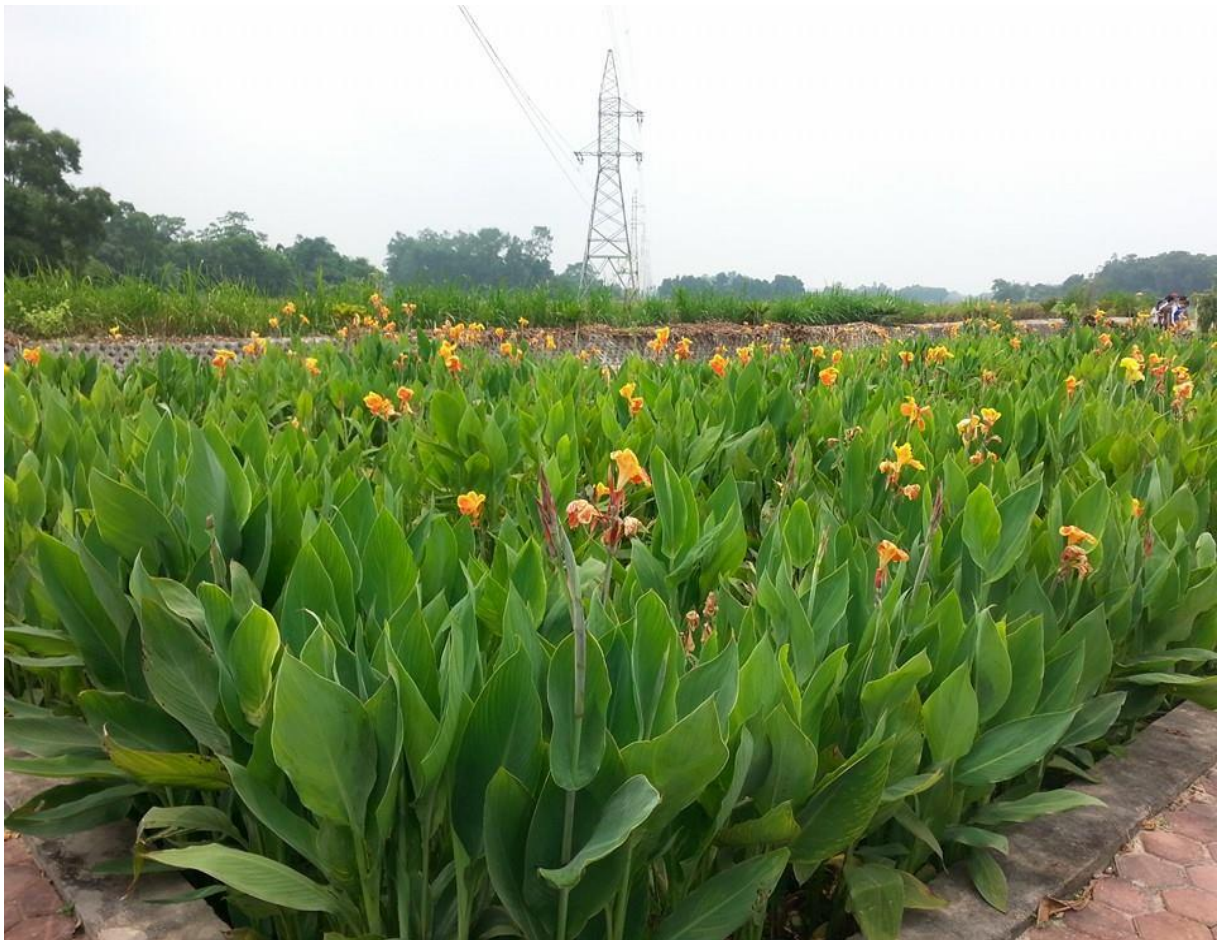
Hình 1.8. Bãi lọc ngầm trồng cây tại thị xã Sông Công (tỉnh Thái Nguyên)
