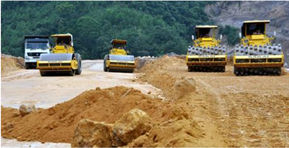
Hình 2.5: Thi công đắp nền đường lớp tại dự án đường vành đai phía bắc tránh thành phố Hạ Long, đoạn Vũ Oai-Quang Hanh
