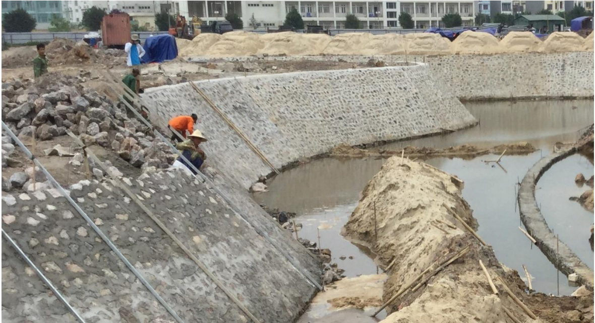
Hình 1.9: Công tác thi công Kè thoát nước mưa
