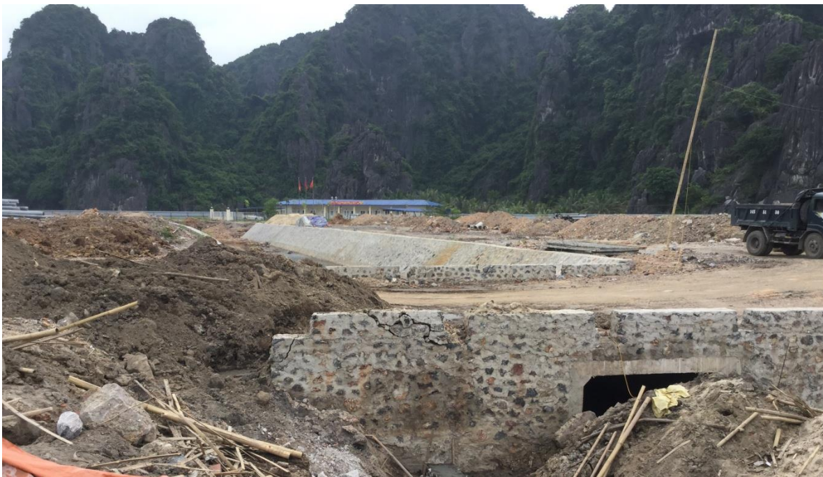
Hình 1.8: Cống hộp thoát nước mưa qua đường
