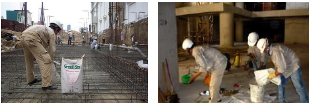
Hình 3.14: Thi công chống thấm GS-200 trên công trường
