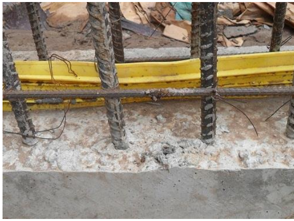
Hình 3.9: Ứng dụng băng cản nước trong chống thấm mạch ngừng bê tông
