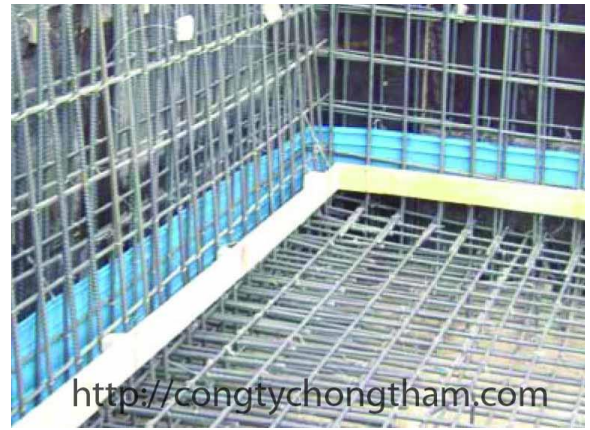
Hình 3.9: Ứng dụng băng cản nước trong chống thấm mạch ngừng bê tông
