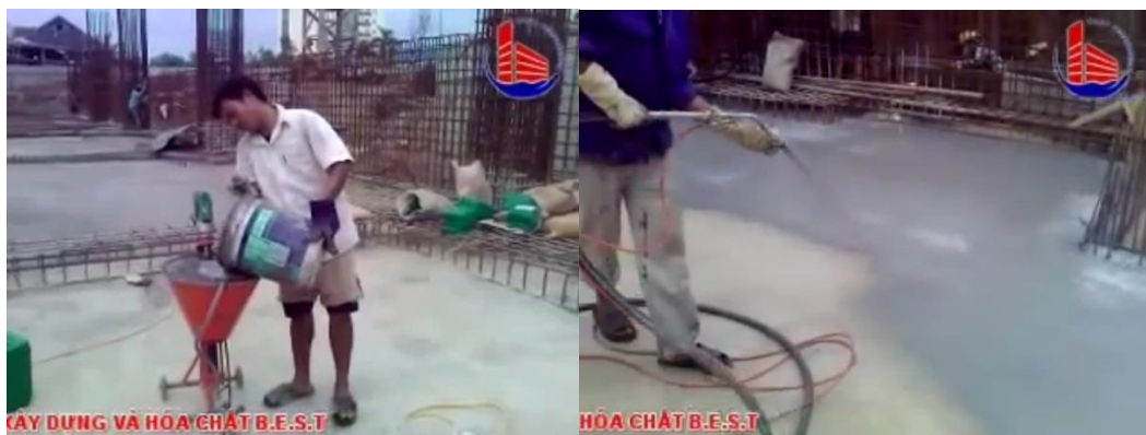
Hình 2.11 : Thi công sơn chống thấm cho sàn tầng hầm
