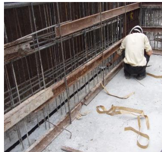
Hình 3.17: Thi công chống thấm mạch ngừng bằng thanh trương nở.
