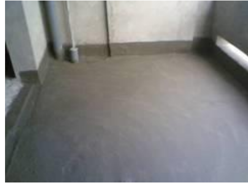
Hình 1.7: Chống thấm tầng hầm công trình Viglacera tower.
