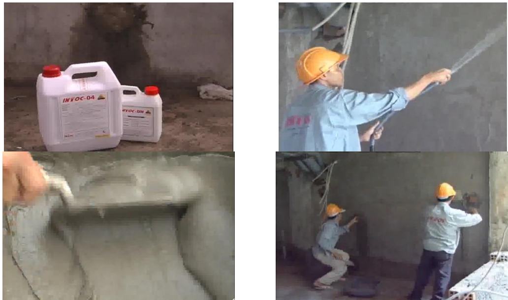
Hình 2.15: Chống thấm vách bê tông bằng vữa trộn phụ gia chống thấm Intoc.
