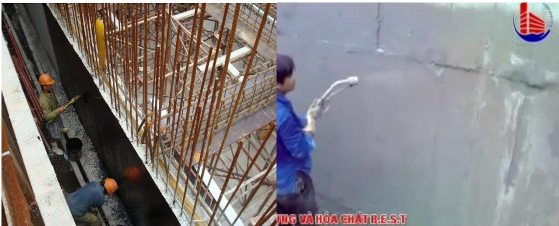
Hình 2.10: Thi công quét và phun sơn chống thấm cho vách bê tông tầng hầm
