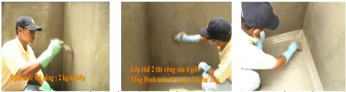
Hình 2.14: Chống thấm bề nước bằng vữa trộn phụ gia chống thấm Sika
