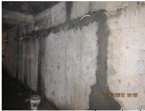
Hình 1.6: Chống thấm tầng hầm công trình PVI tower.
