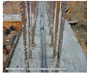
Hình 3.17: Thi công chống thấm mạch ngừng bằng thanh trương nở.
