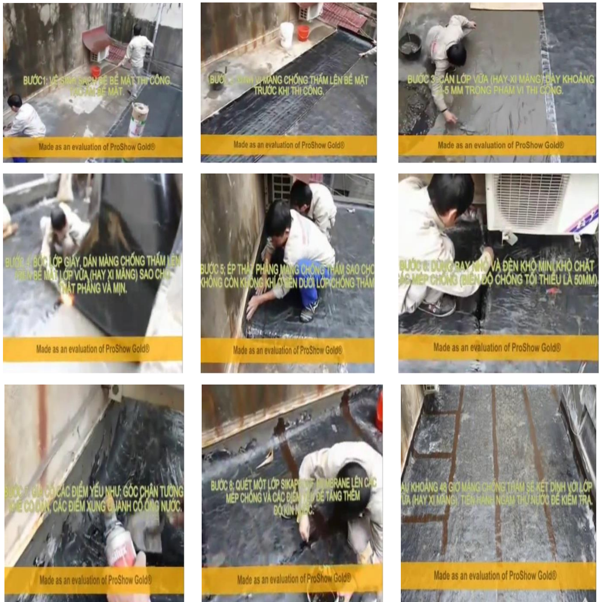
Hình 2.12 : Thi công chống thấm cho sàn tầng hầm bằng màng chống thấm tự dính
