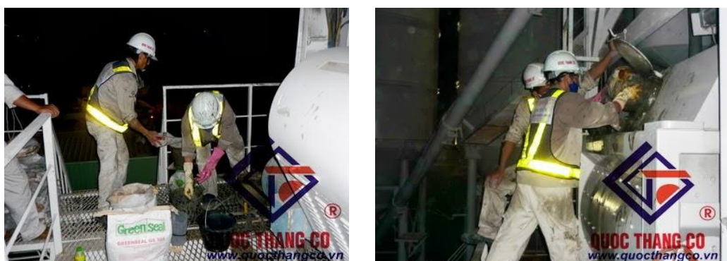
Hình 3.11: Sử dụng phụ gia chống thấm GS-100 tại trạm trộn bê tông
