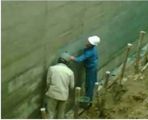
Hình 1.7: Chống thấm tầng hầm công trình Viglacera tower.
