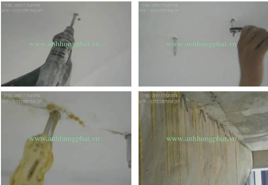
Hình 2.17: Bơm chống thấm khe, kẽ nứt bê tông
