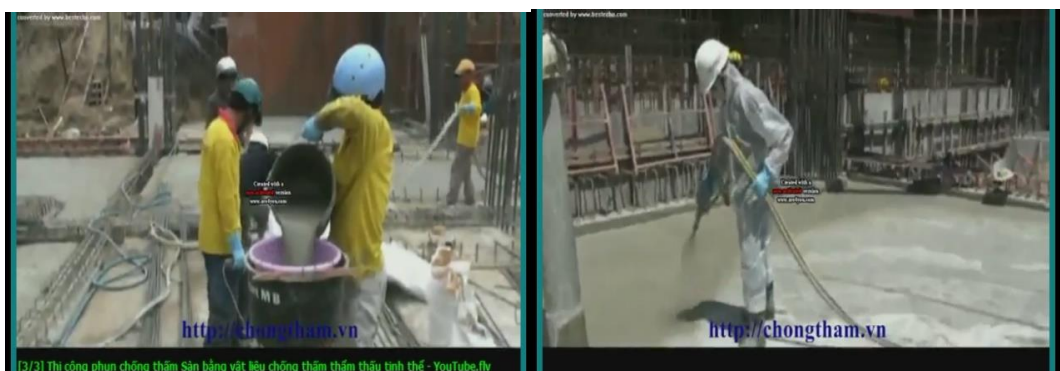
Hình 2.18: Phun chất chống thấm tinh thể lên mặt sàn bê tông
