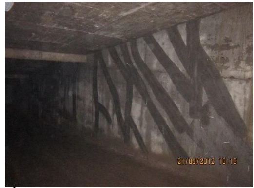
Hình 1.6: Chống thấm tầng hầm công trình PVI tower.
