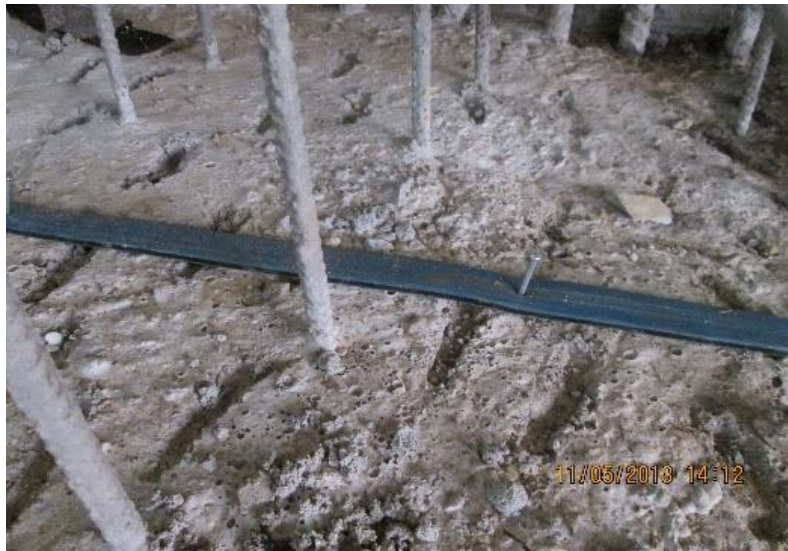
Hình 3.6: Lắp đặt Sika hydrotile CJ-type tại mạch ngừng thi công.
