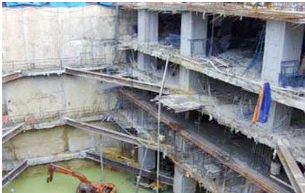
Hình 1.8. Hầm móng của công trình Pacific 5 tầng hầm [8]
