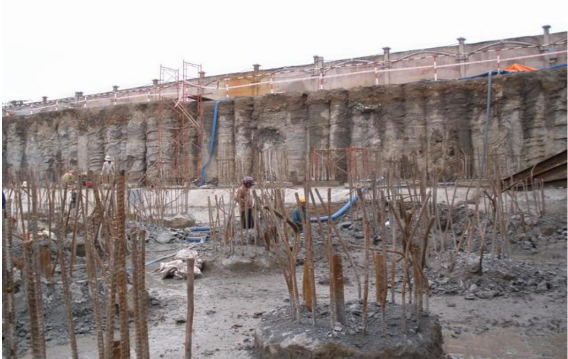
Hình 1.15. Giữ ổn định hố đào bằng hệ cọc xi măng đất [8]
