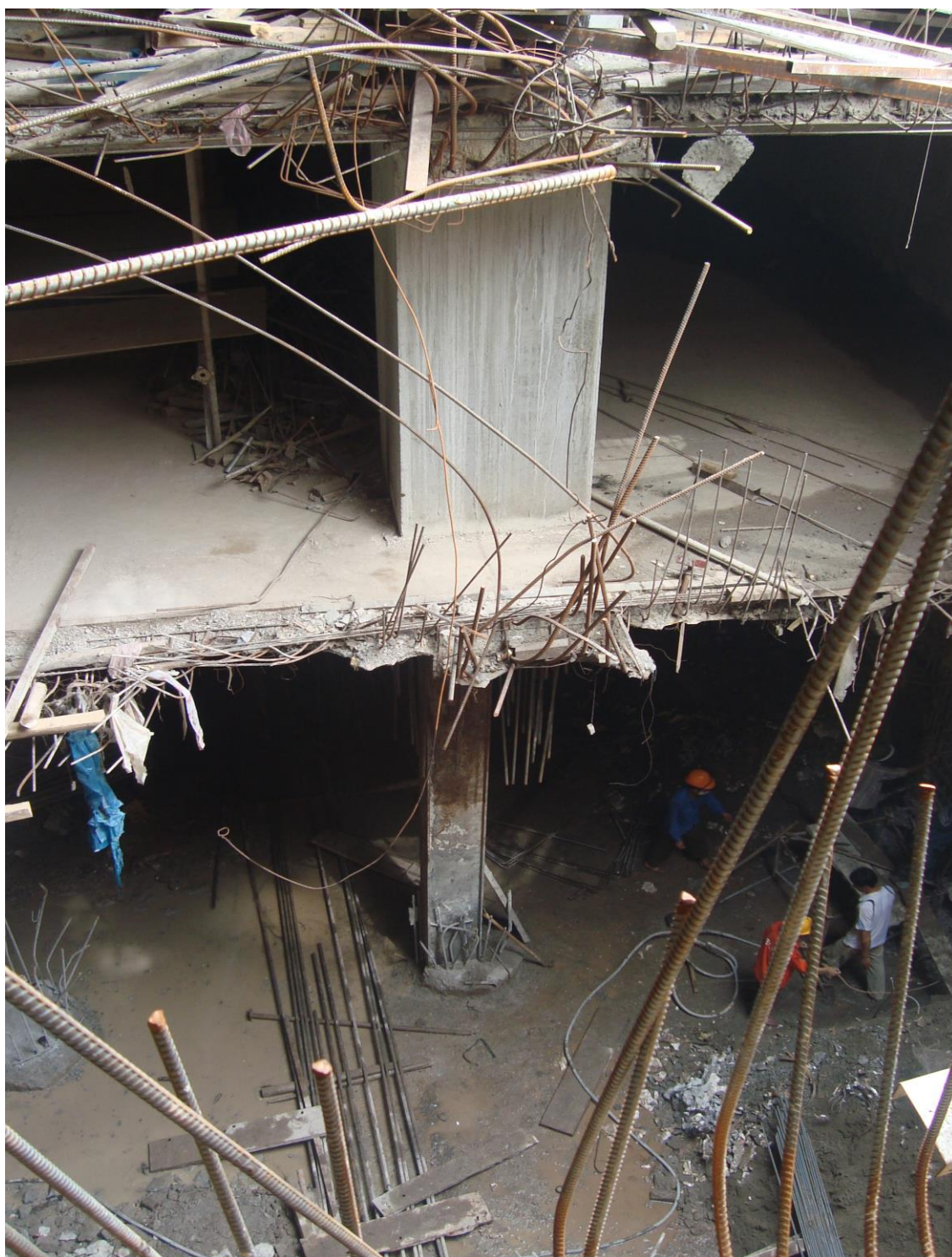
Hình 1.2. Thi công Top – Down phân ngầm [8]
