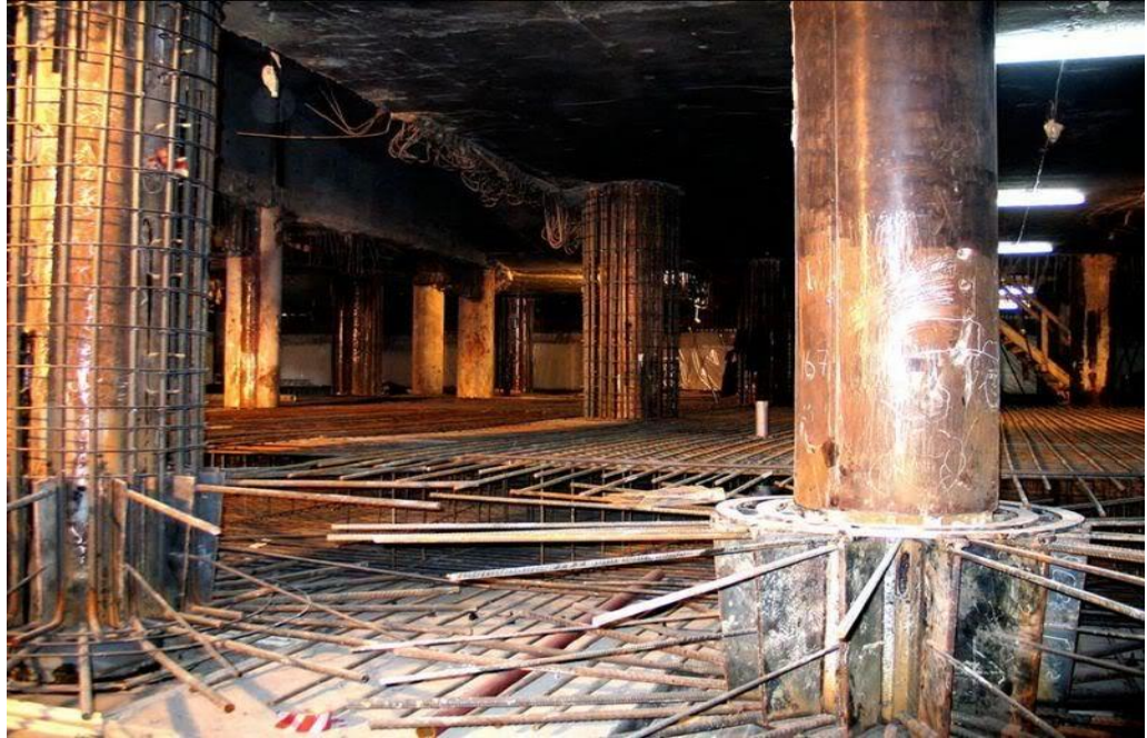
Hình 1.5. Hệ thống cột chống Kingpost [8]
