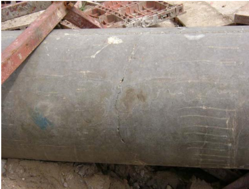
Hình 4.4 Sự cố nứt cọc khi vận chuyển
