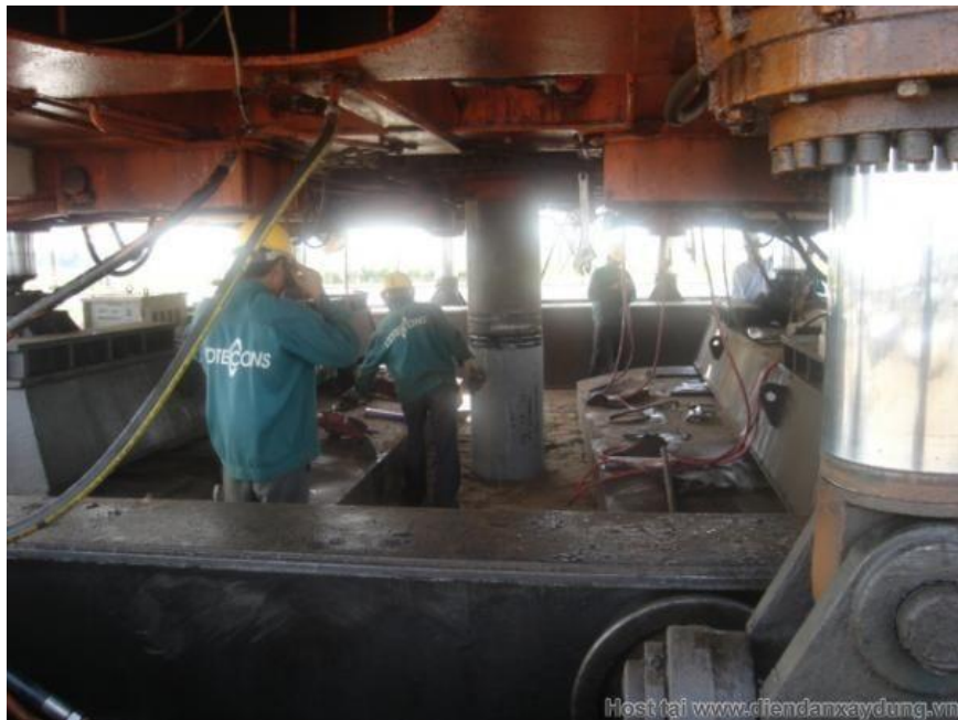
Hình 4.2 Công tác nối cọc ở công trường.
