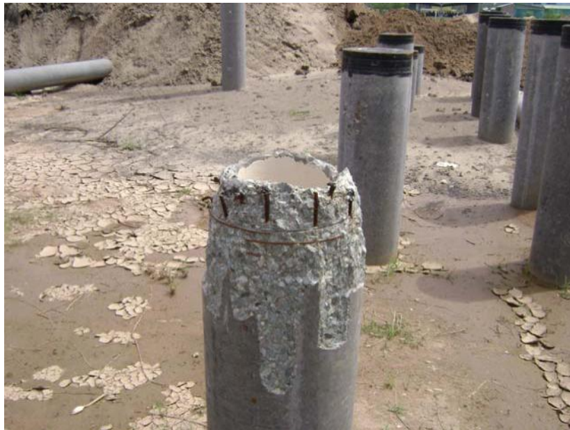
Hình 4.3 Bề đầu cọc khi ép.
