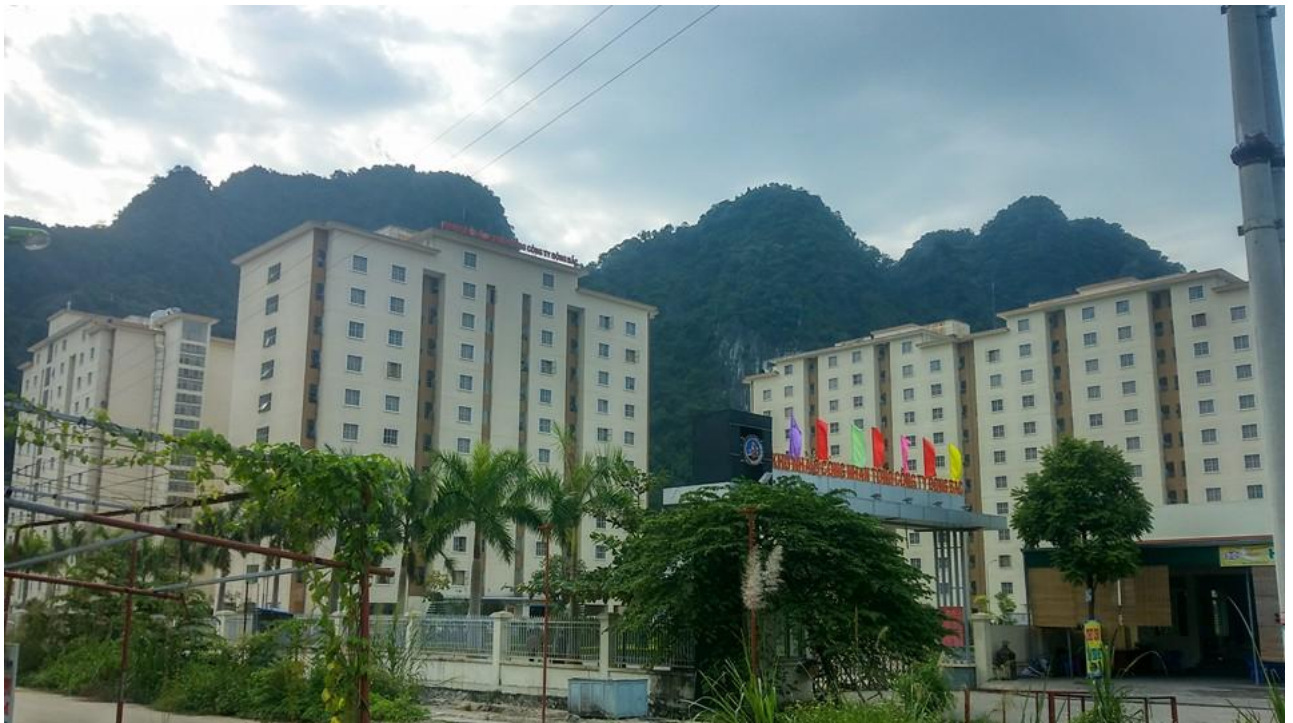
Hình 1.3.3. ảnh chụp toàn cảnh khu nhà ở công nhân công ty Đông Bắc.
