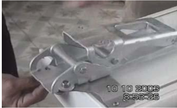
Hình 3.3. Lắp bộ chỉnh góc ngả anten
