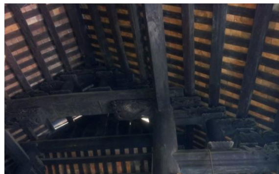
Hệ thống cửa võng và kết cấu vì kèo Đình An Biên
