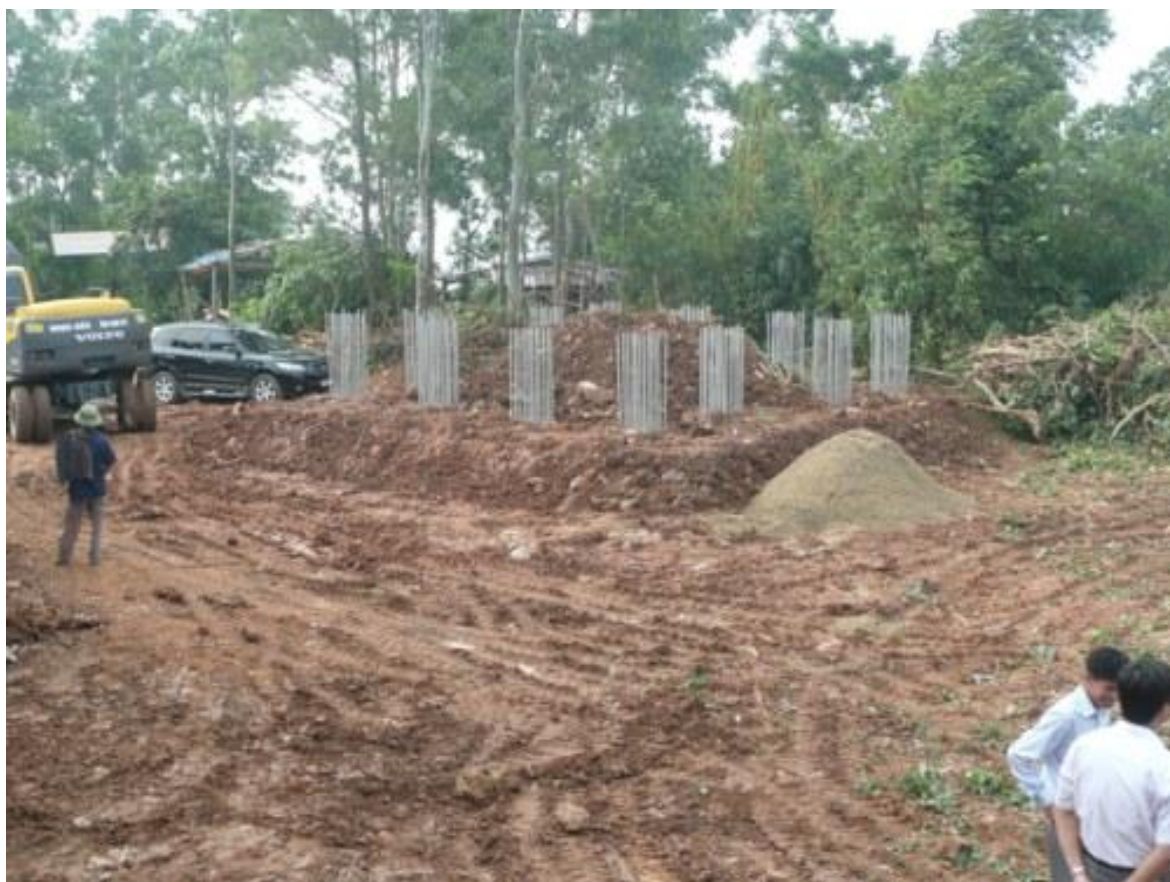
Móng tháp chuẩn bị phục dựng
