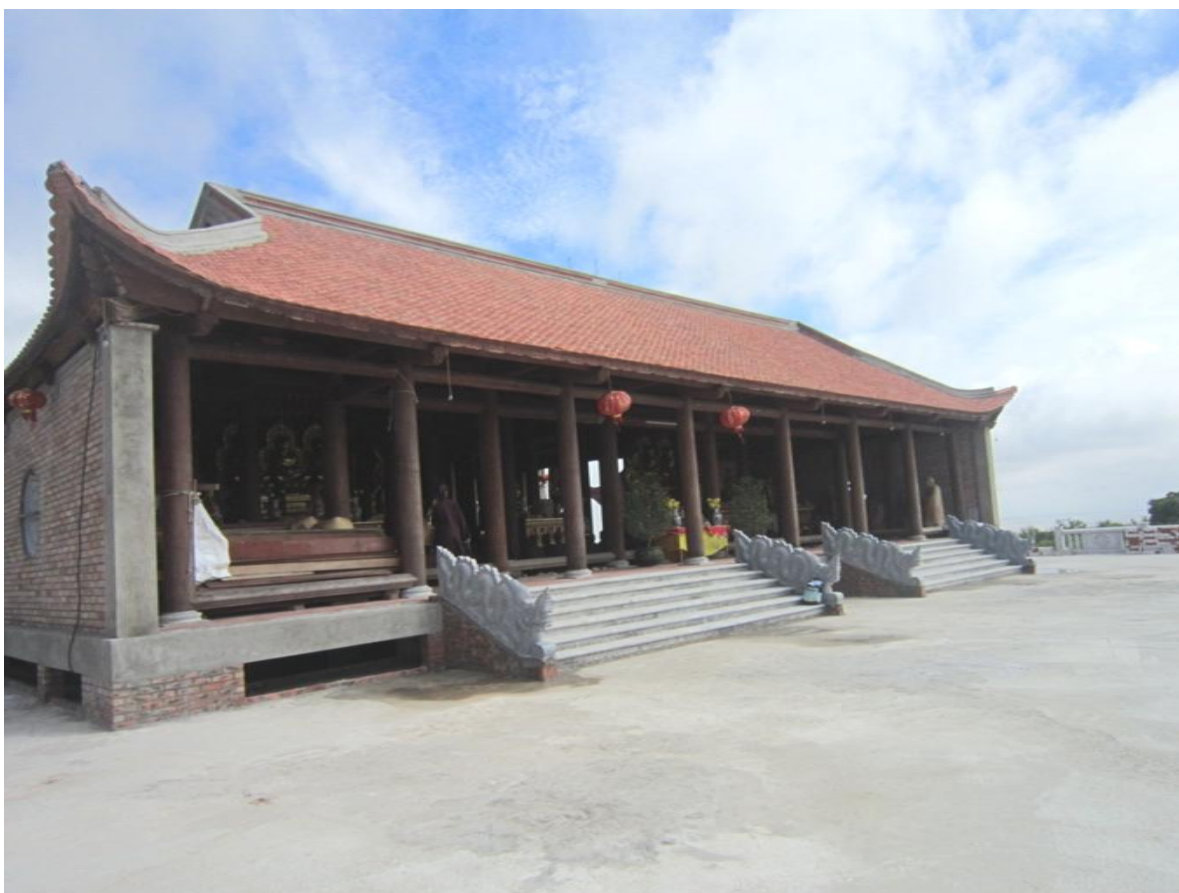
Chùa Tường Long đang được xây dựng
