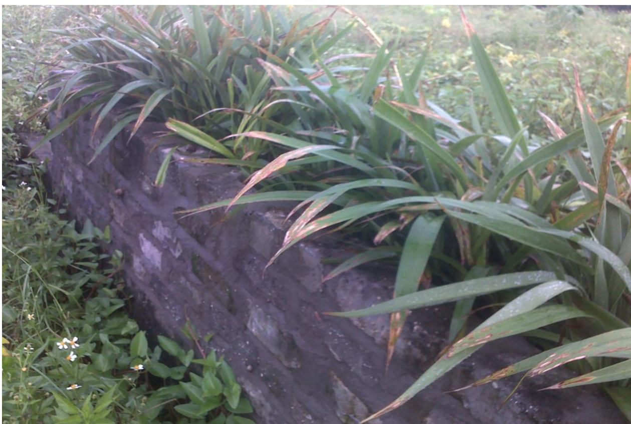
Hình 2.3. Hình ảnh hệ thống bể lọc ngầm trồng cây dòng chảy đứng
