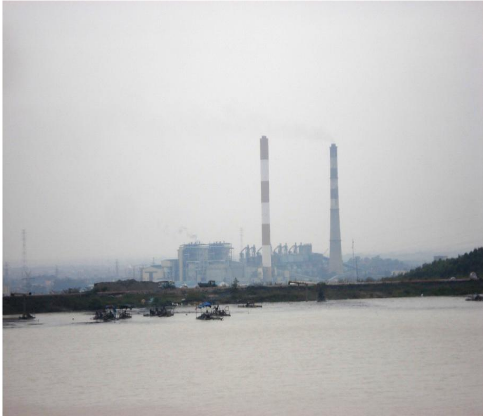
Hình 1.1. Nhà máy Nhiệt Điện Phả Lại.
