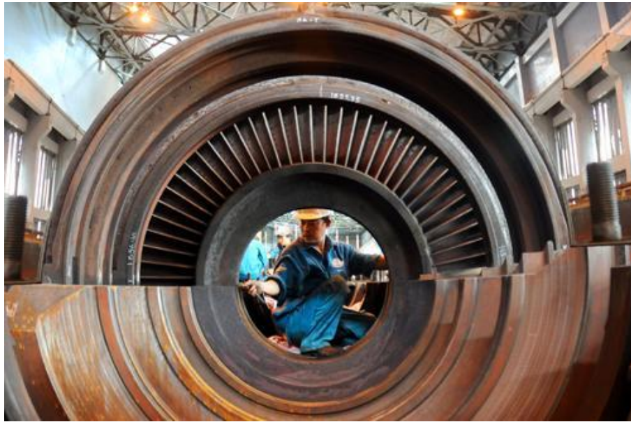
Hình 1.4. Tua bin nhà máy nhiệt điện Phả Lại
