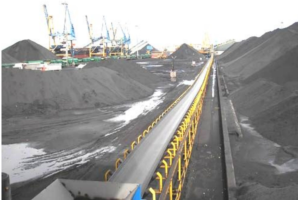
Hình 1.2. Băng tải than nhà máy Nhiệt Điện Phả Lại.
