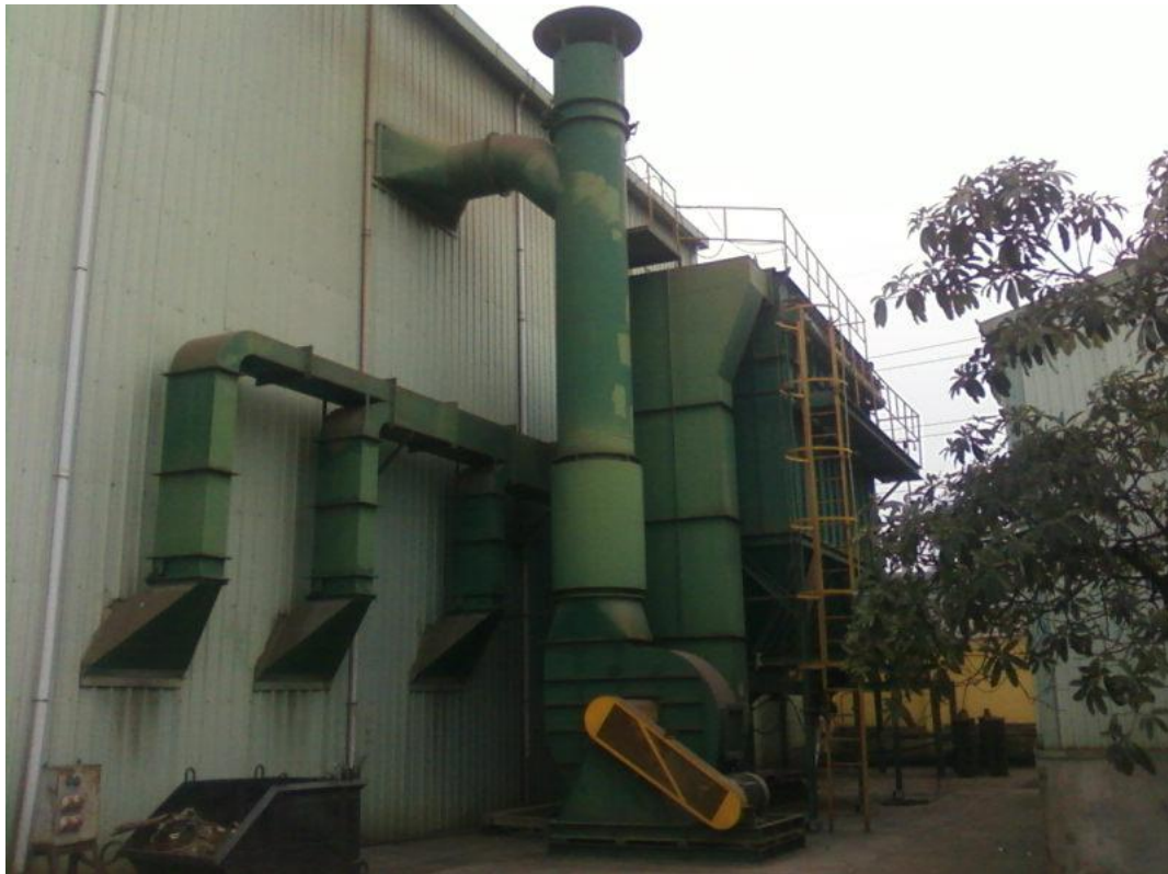
Hình 3.6. Hệ thống lọc bụi của Công ty
