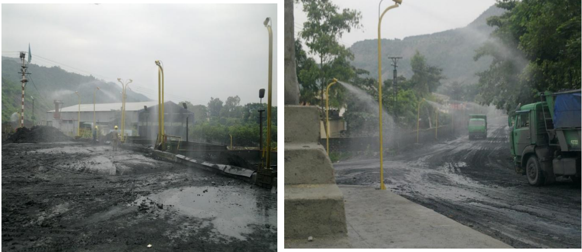
Hình 3.4: Hệ thống phun sương tự động tại tuyến đường xe chạy và khu rớt than.
