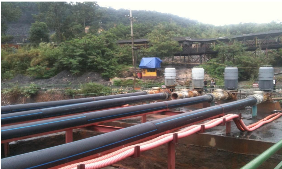
Hình 3.5: Hệ thống bơm nước thải khai thác.
