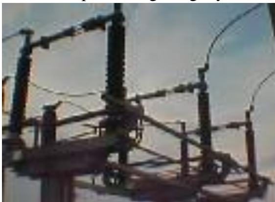
Hình2.3. Dao cách ly SGF 123 kV
