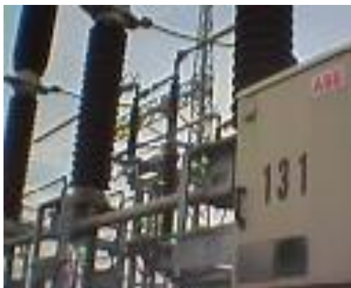
Hình 2.2. Máy cắt khí SF6 – 110kV ELF – SL3 -1
