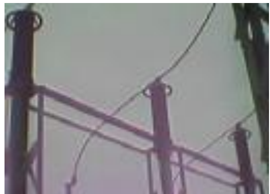
Hình 2.8. Chống sét van phân 110 Kv kiểu pexlimvo96-AH123
