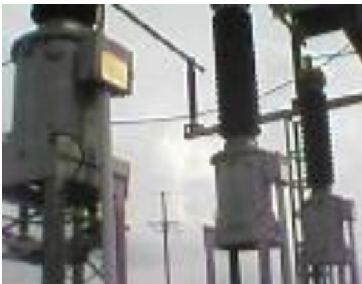
Hình2.6. Máy biến điện áp 110 kV, CV - 115
