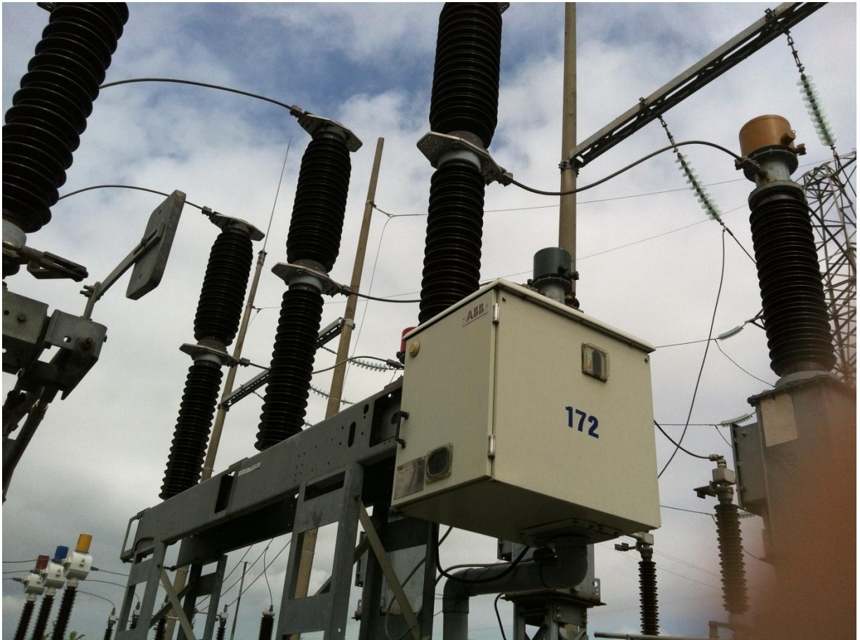
Hình 2.4: Máy cắt
