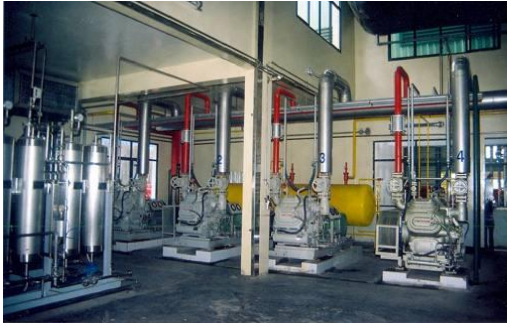
Hình 1.19. Hệ thống nén lạnh
