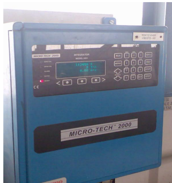
Hình 2.4 : Thiết bị cân than trên băng
