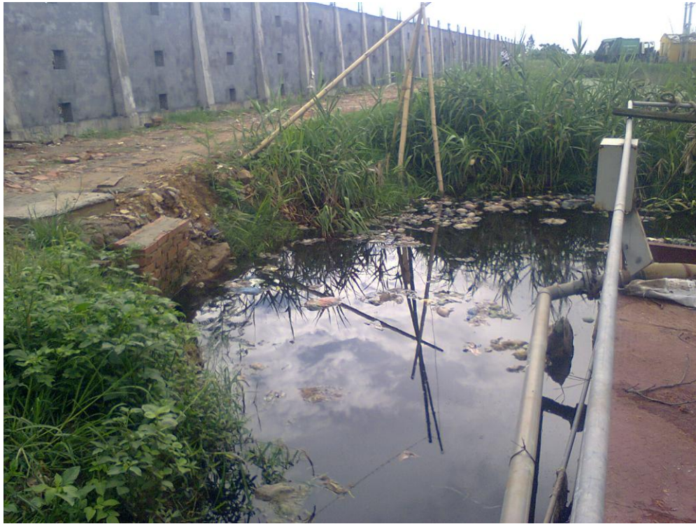
Hình 3.4. Hồ thu gom nước rỉ rác
