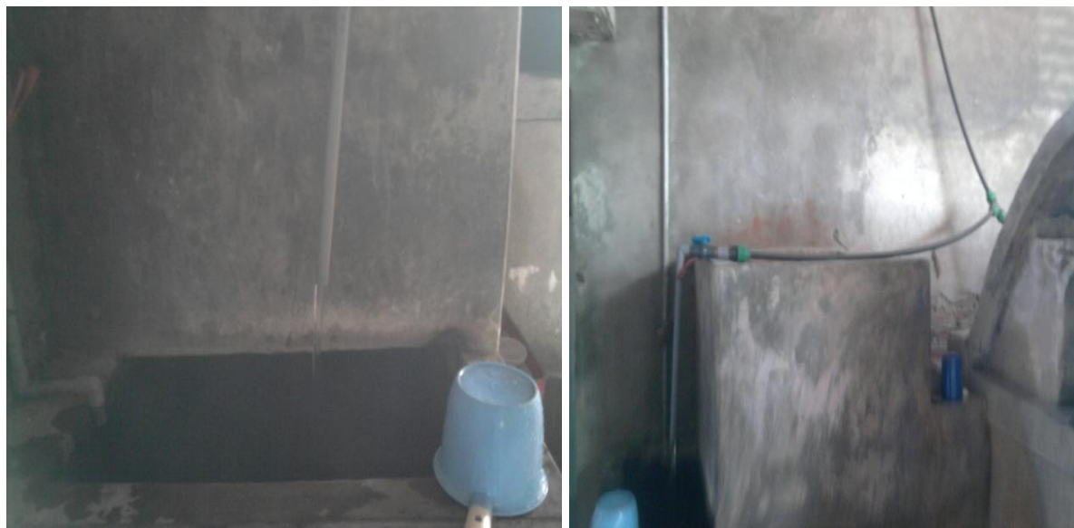
Hình 2.6: Ảnh nước lọc cung cấp nước cho bể chứa nước sinh hoạt phía dưới
