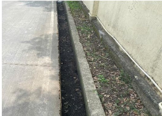
Hình 2.4 Hình ảnh rãnh thoát nước mưa của nhà máy
