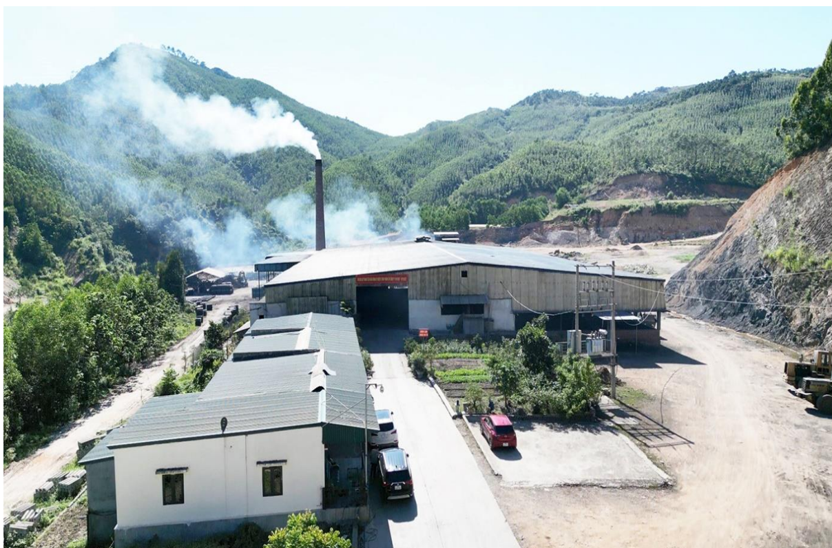
Hình ảnh 7: Nhà máy rác Khe Giang công suất hỏa thiêu 750 tấn/rác/ngày, cơ sở đốt rác được triệt để và đốt rác khi rác chưa phân loại từ nguồn.
