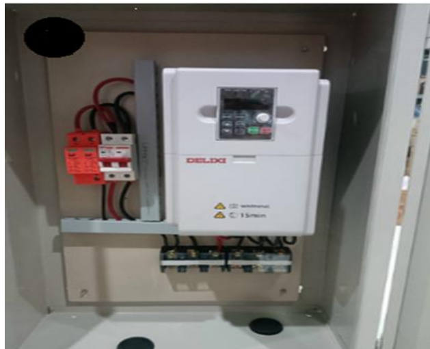
Hình 3.6: Cách đấu nối mạch động lực thực tế
