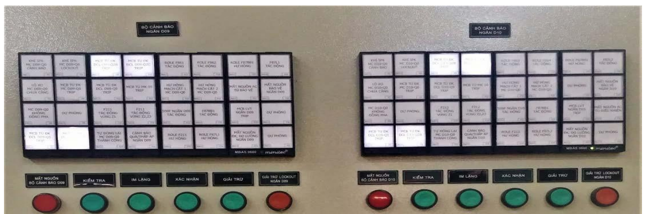
Hình 2.3 – Bảng giám sát hệ thống điều khiển truyền thống
