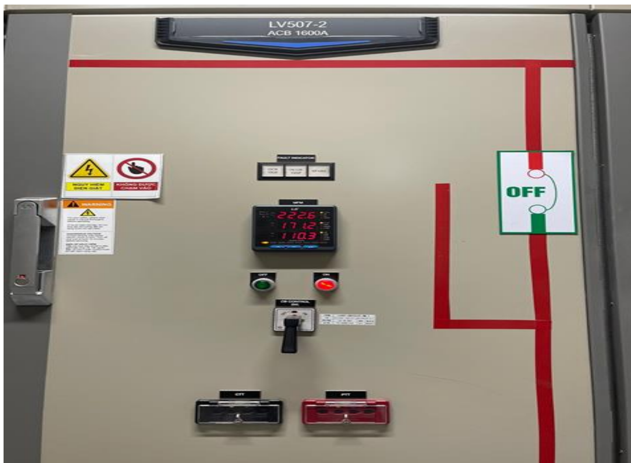
Tủ điện nhánh cho từng chuyền sản xuất (trạng thái ON)
