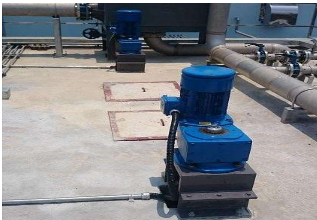
Hình 3.4: Động cơ khuấy trộn nước thải
