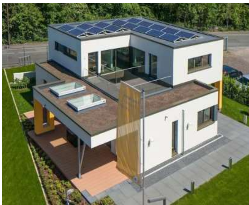
Hình 1.3. Điện mặt trời cho tòa nhà.
