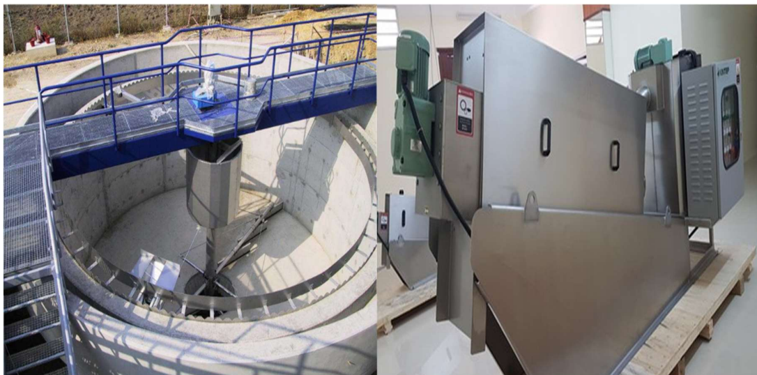
Hình 2.14. Bể và máy ép bùn trục vít
