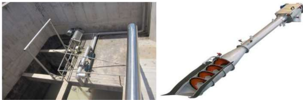
Hình 2.6. Hình ảnh minh họa của Hố bơm và Thiết bị tách rác trục vít
