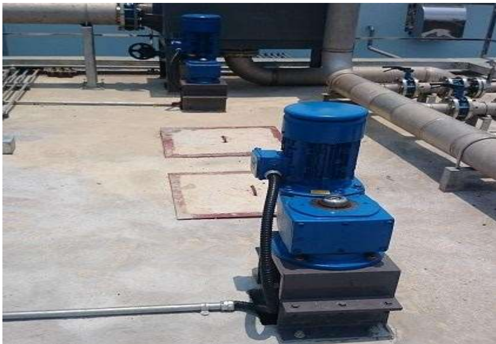
Hình 3.4: Động cơ khuấy trộn nước thải
