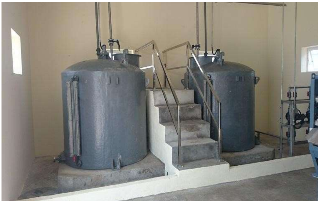
Hình 3.5: Cụm các bồn chứa hóa chất
