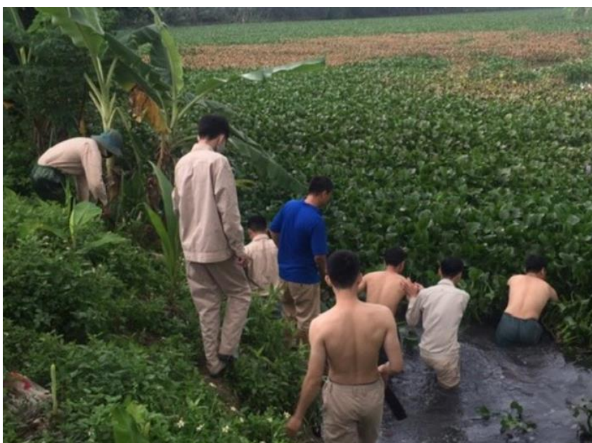
Hình 2.3: Hình ảnh công tác vớt bèo khơi thông dòng chảy
