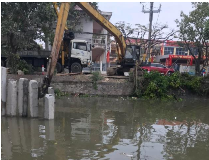
Hình 2.2 : Hình ảnh công tác tháo dỡ xử lý vi phạm lấn chiếm
