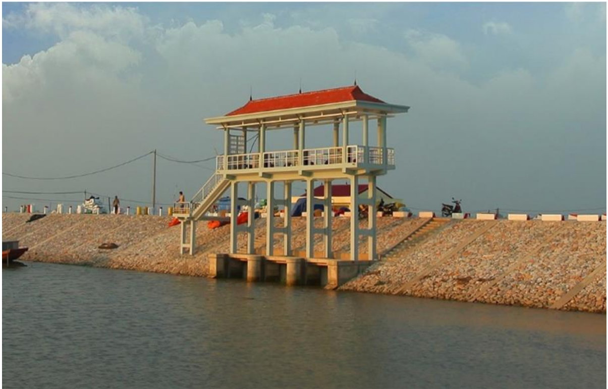
Hình 3.1. Công trình cống Đồng Thêo mới - Dự án cải tạo, nâng cấp hệ thống thủy nông Đa Độ giai đoạn 2
