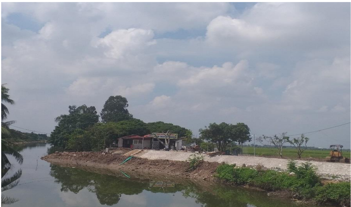
Hình 1.2. Trường hợp vi phạm hành lang sông Chanh Dương tại xã Thắng Thủy.
