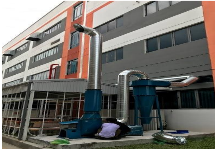
Hình 3.1. Hệ thống hút và lọc bụi bằng clycone
