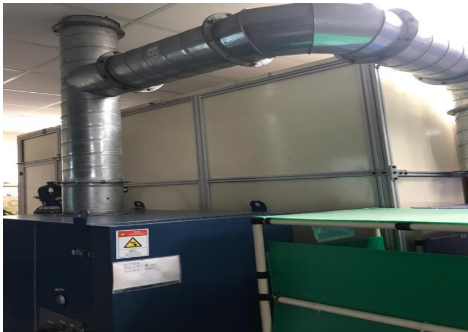
Hình 3.4. Hình ảnh HTXL khí hàn khép kín
