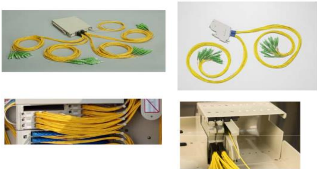
Hình 10. Splitter và vị trí trong FDH
