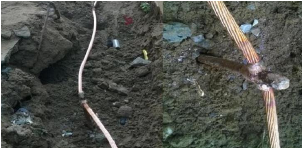
Hình 3.11. Thi công nối cọc tiếp địa
