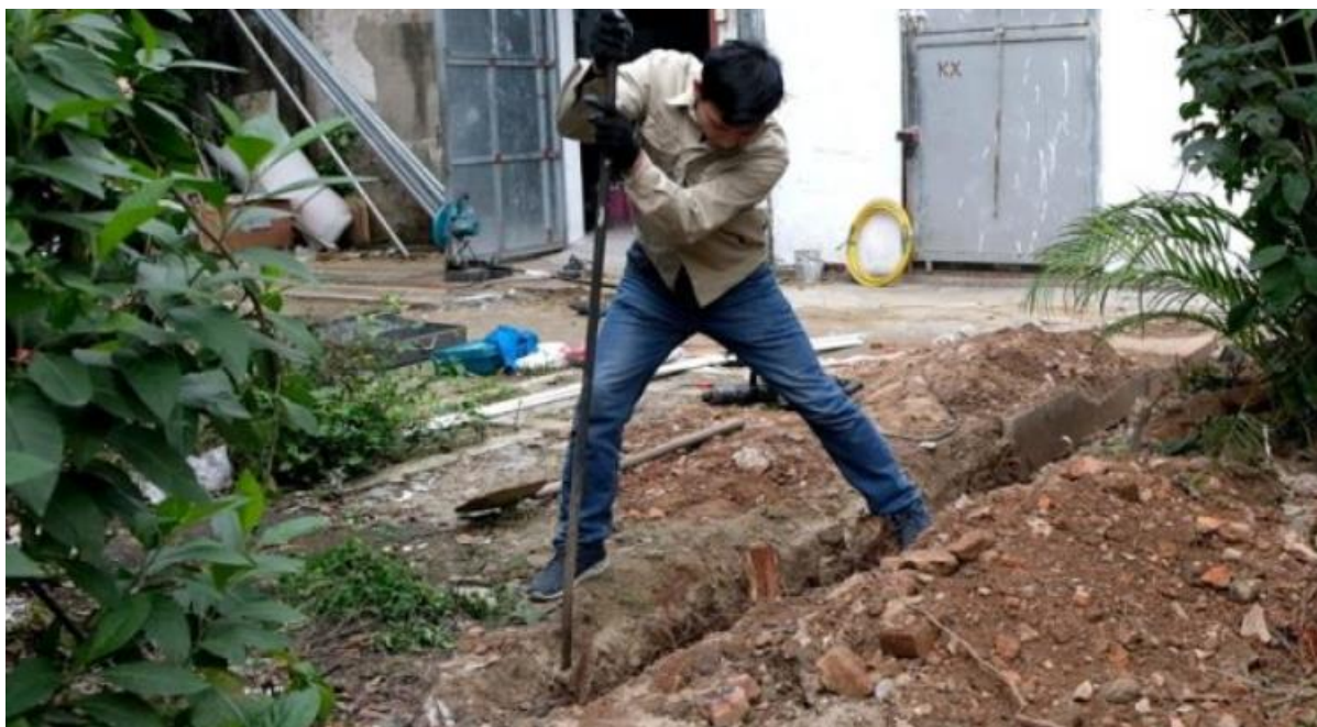
Hình 3.10.Thi công đào rãnh tiếp địa
