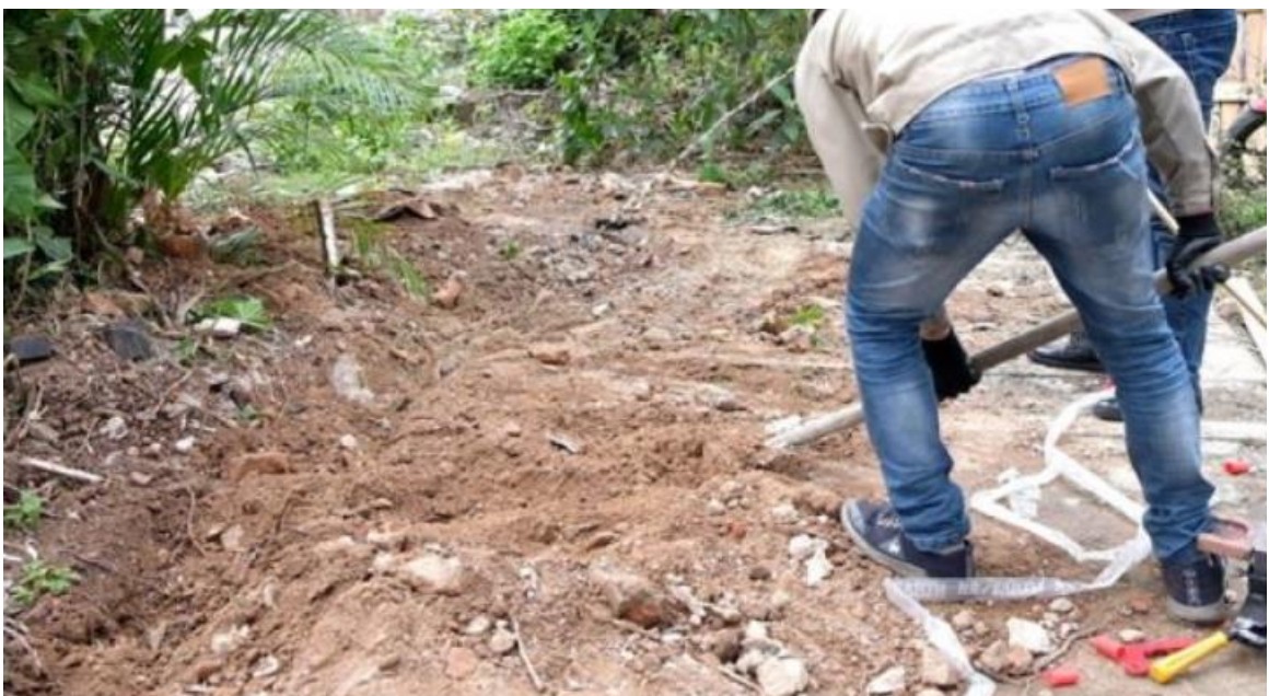
Hình 3.12. Lấp đất hoàn trả mặt bằng
