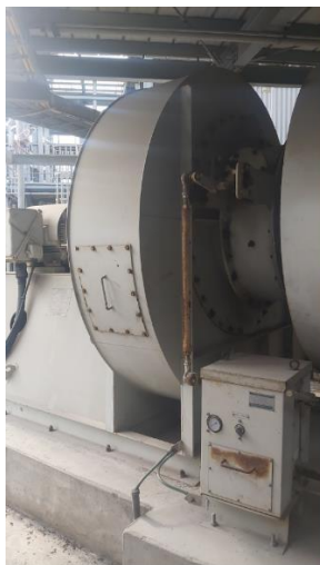
Hình 3.10: Van 62FV611A đóng mở Ramper
