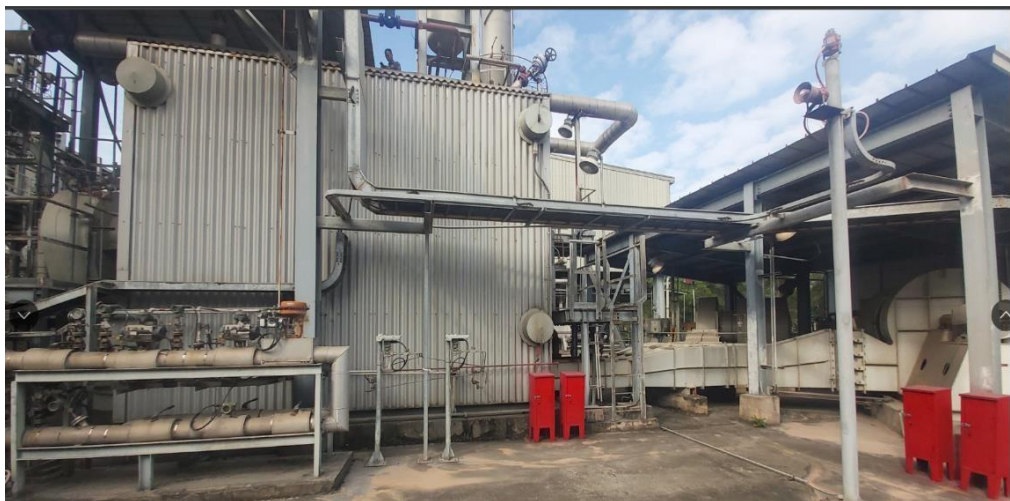
Hình 3.2: Kiểu dáng nồi hơi ống nước
