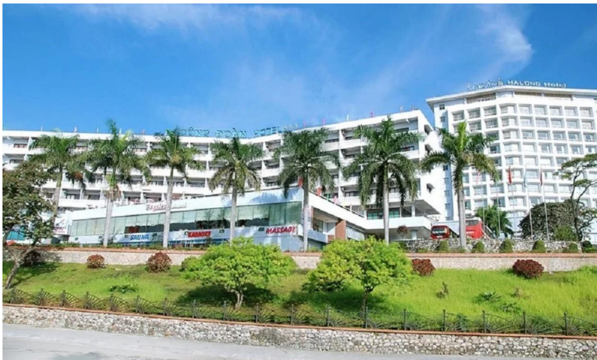
Khách sạn Công Đoàn Hạ Long, Quảng Ninh
