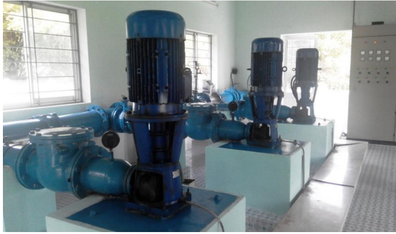
Hình 2.2.1.4: Trạm bơm 3000 m 3 /ngày – nhà máy nước Phước Sơn tỉnh Bình Định
