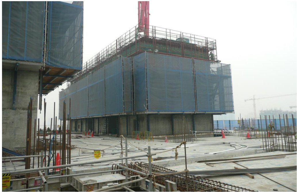
3.6b. Hình ảnh thi công côpha lõi tòa nhà Keangnam. [tác giả sưu tầm]
