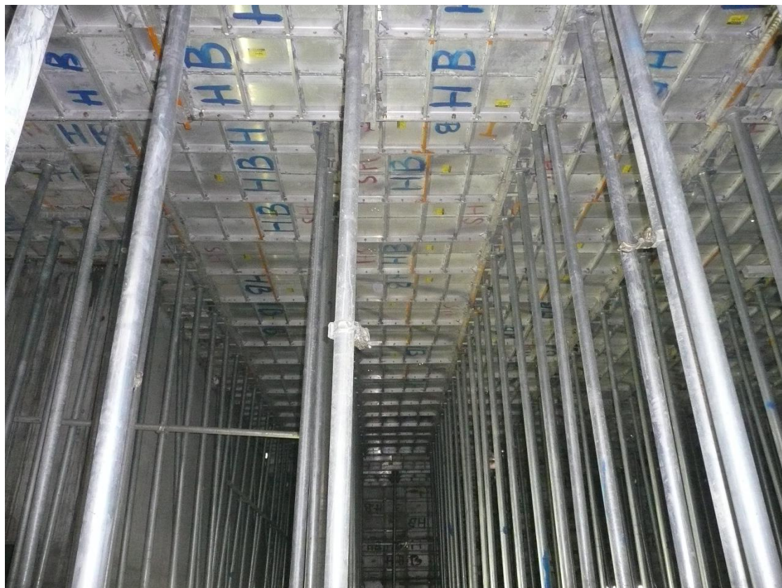
Hình 2.3 Cốppha và cây chống sàn. [tác giả sưu tầm]
