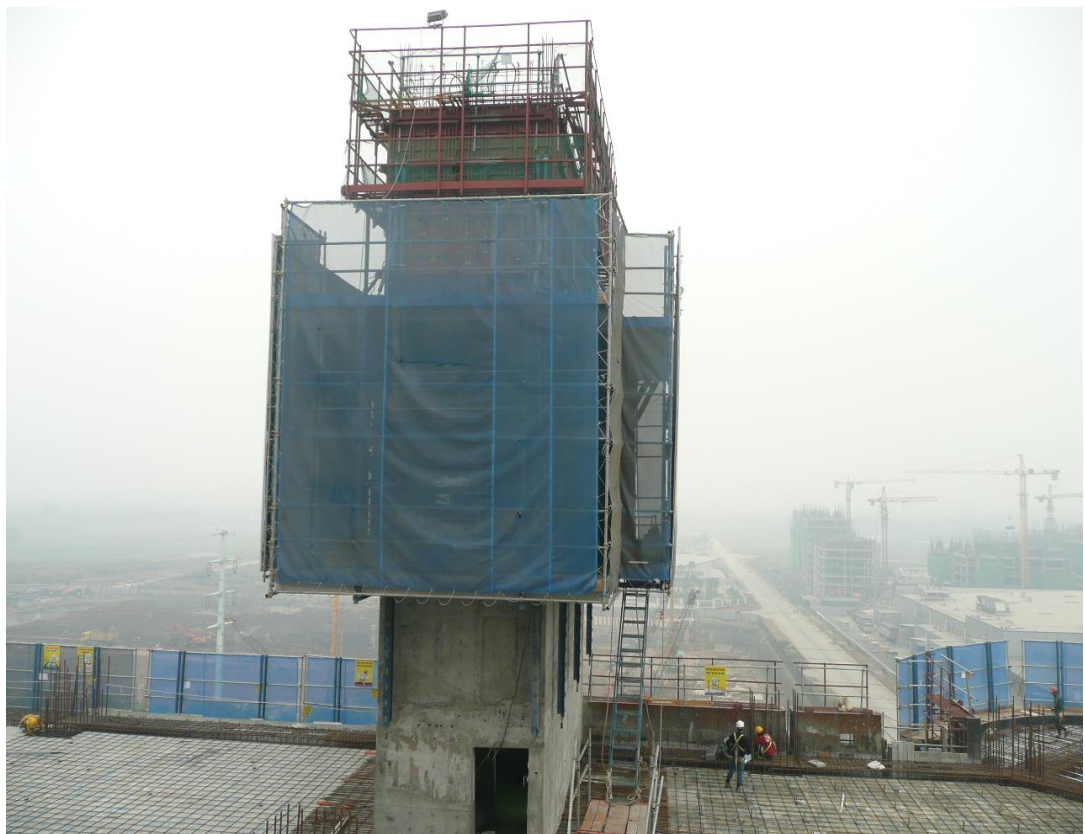
3.6b. Hình ảnh thi công côpha lõi tòa nhà Keangnam. [tác giả sưu tầm]
