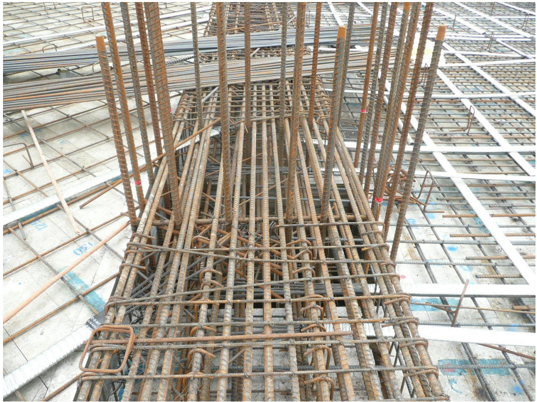
3.7c. Hình ảnh thi công liên kết thép sàn vào lõi. [tác giả sưu tầm]
