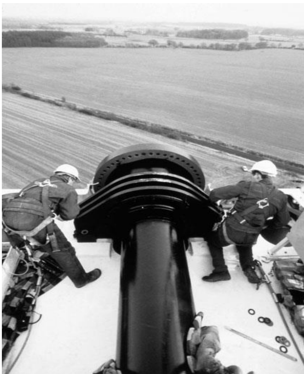
Hình 1.14: Lắp đặt trục quay của tuabin vào tháp gió.
