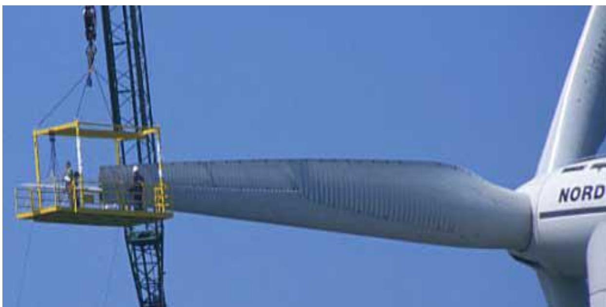
Hình 1.15: Lắp ráp cánh của tuabin vào bộ phận chính của rotor.
