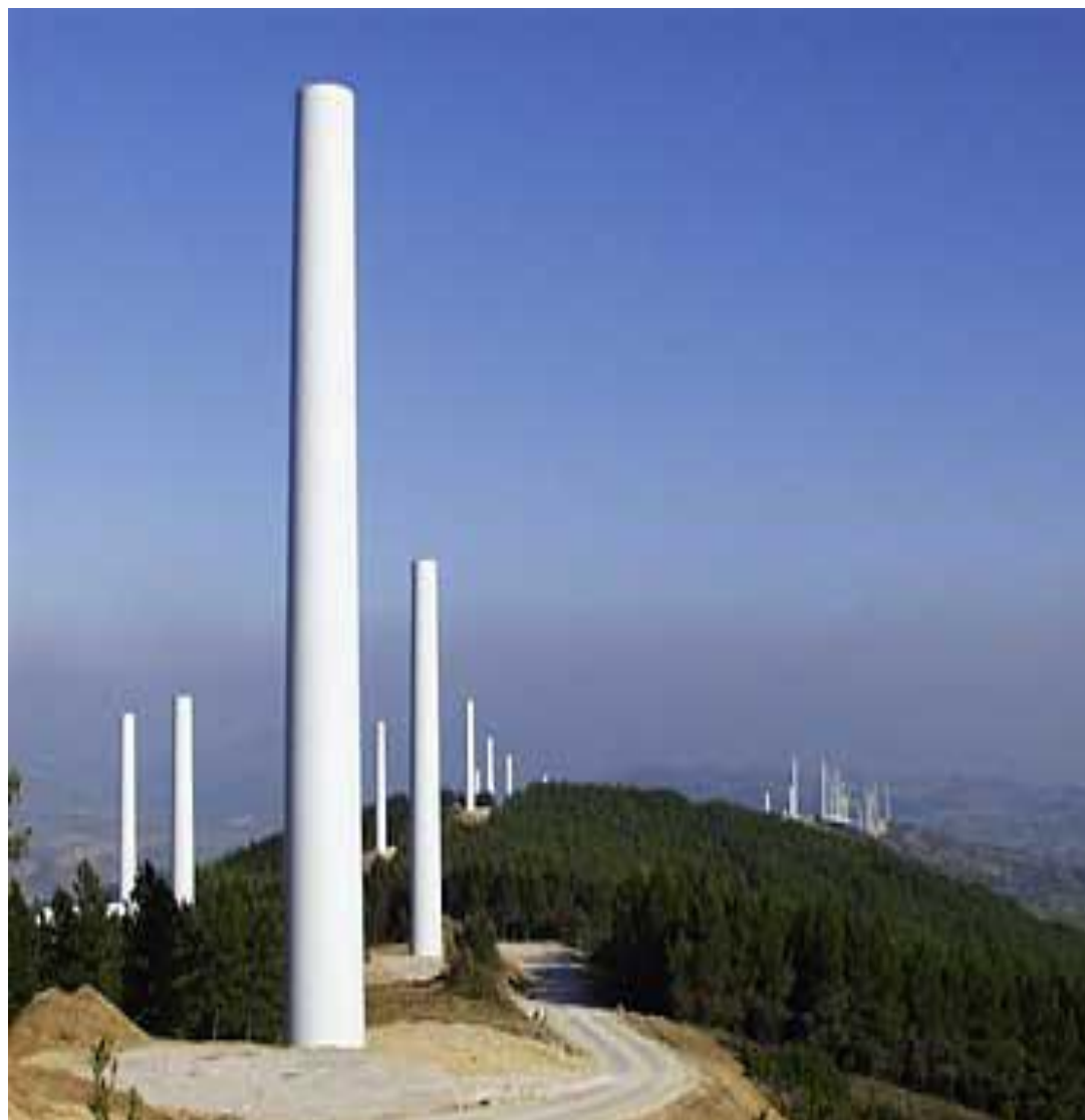
Hình 1.12: Xây dựng nền móng và thân tháp gió.
