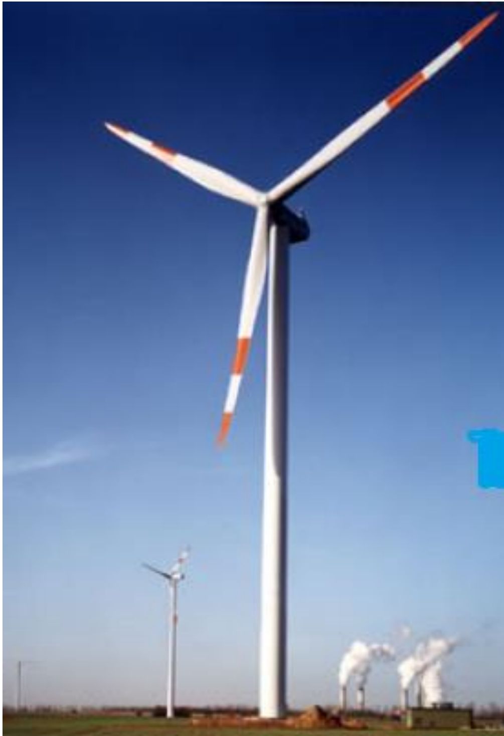
Hình 1.4: Tuabin 2.5MW có đường kính cánh 80m
