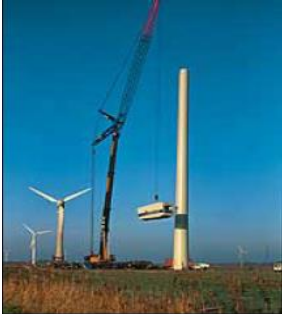
Hình 1.13: Lắp đặt tuabin vào thân tháp gió.
