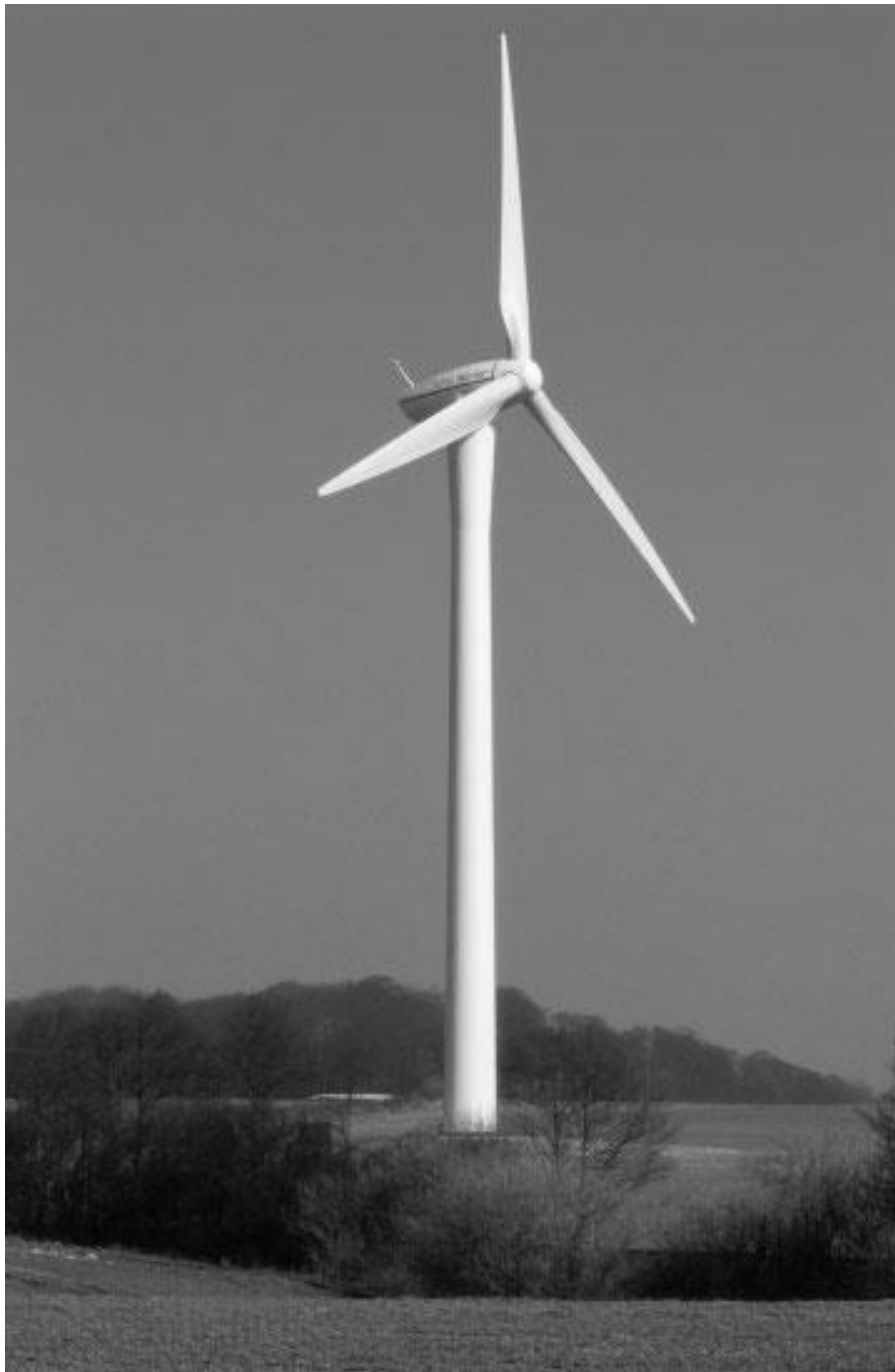
Hình 1.6: Tuabin 1.5MW có đường kính cánh 64m.
