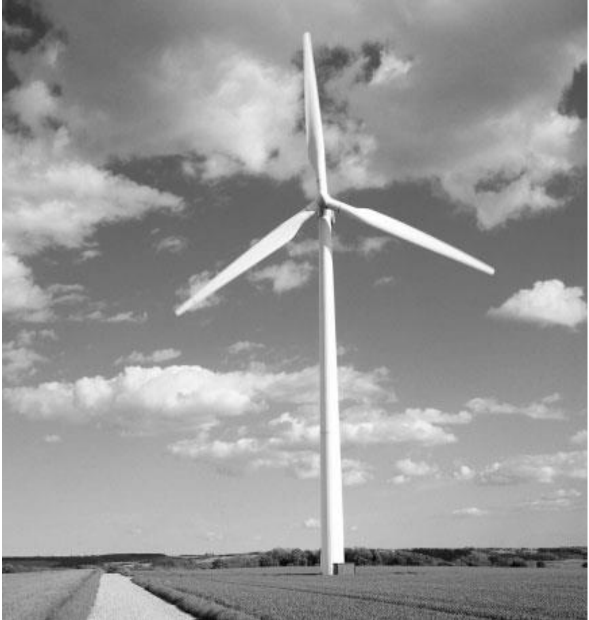
Hình 1.5: Tuabin 750kW có đường kính cánh 48m của Denmark.
