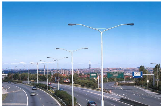
Hình 2.5: Bố trí đèn trên dải phân cách trung tâm
