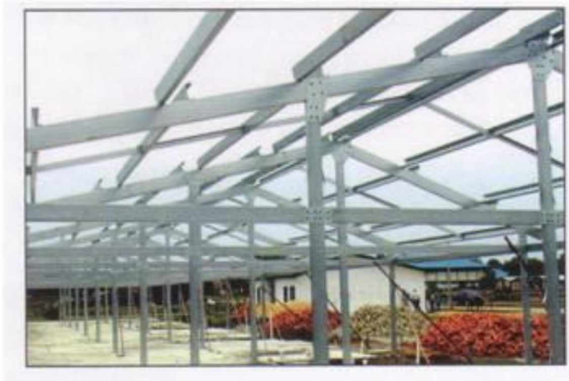
Hình 1.5. Nhà xưởng làm hoàn toàn bằng cấu kiện thành mỏng tạo hình ngưỡi
