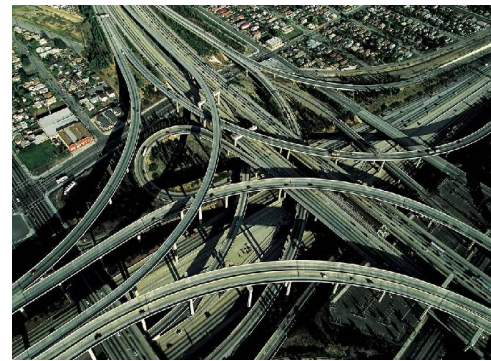
Nút giao thông nhiều tầng
