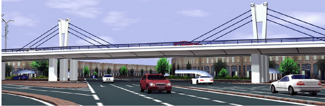
Hình 2.32: Kết cấu nhịp cầu Extrados (Cầu vượt Ngã Tư Sở)
