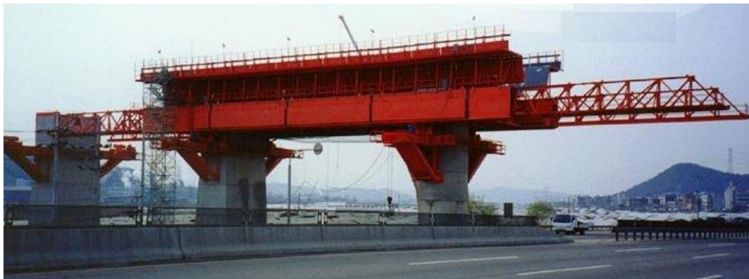
Hình 2.45 b, c: Biện pháp đúc dầm tại chỗ trên đà giáo đẩy dưới đúc trên
