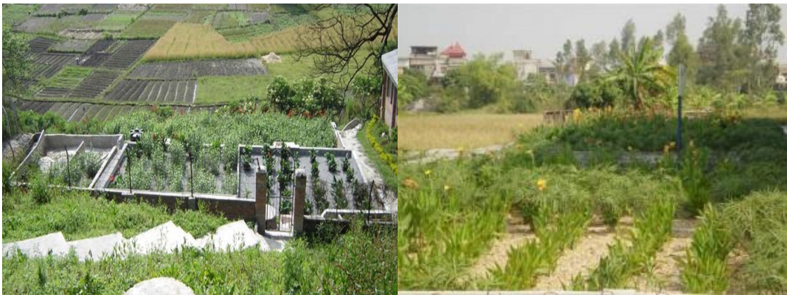
Hình 1.2. Hệ thống xử lý nước thải tại Bệnh viện Đa khoa Kim Bảng, tỉnh Hà Nam (Công suất: 125m 3 /ngày đêm)
