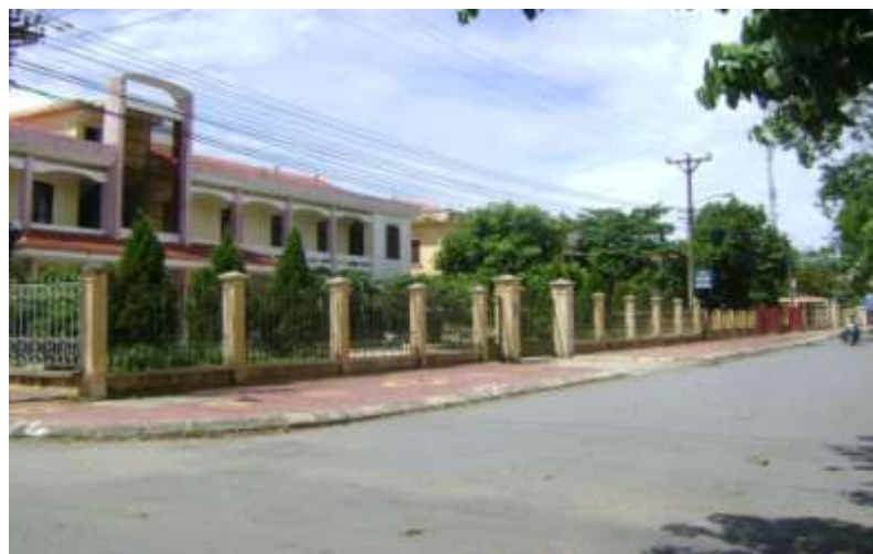
Dây điện trên đường khu hành chính
