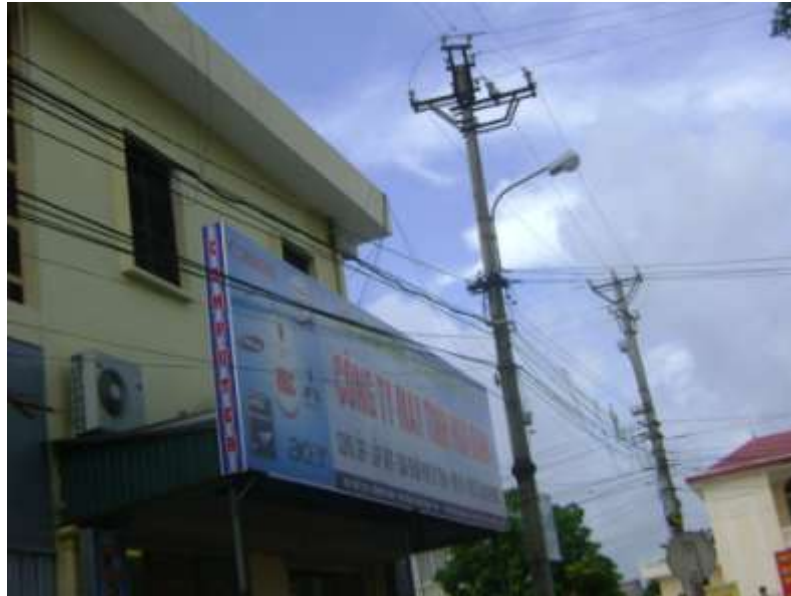
Dây điện chằng chịt trên tuyến đường
